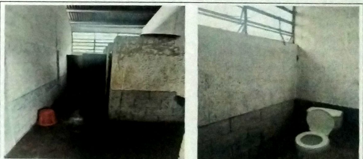
Foto 4: MODULO DE SERVICIO SANITARIO, Fase de picado de superficie en paredes.
