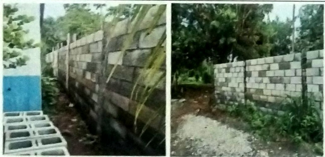
Foto 3: TRABAJOS EXTERIORES, Sanjeo para muro perimetral Vista norte sur y sur norte. Fase de levantado de block con columnas.
