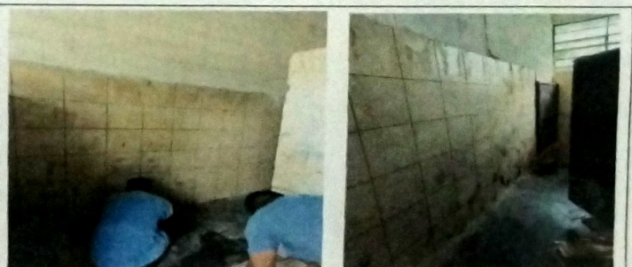
Foto 6: MODULO DE SERVICIO SANITARIO, Fase de picado de superficie en paredes. Se esta instalando azulejo en muros
